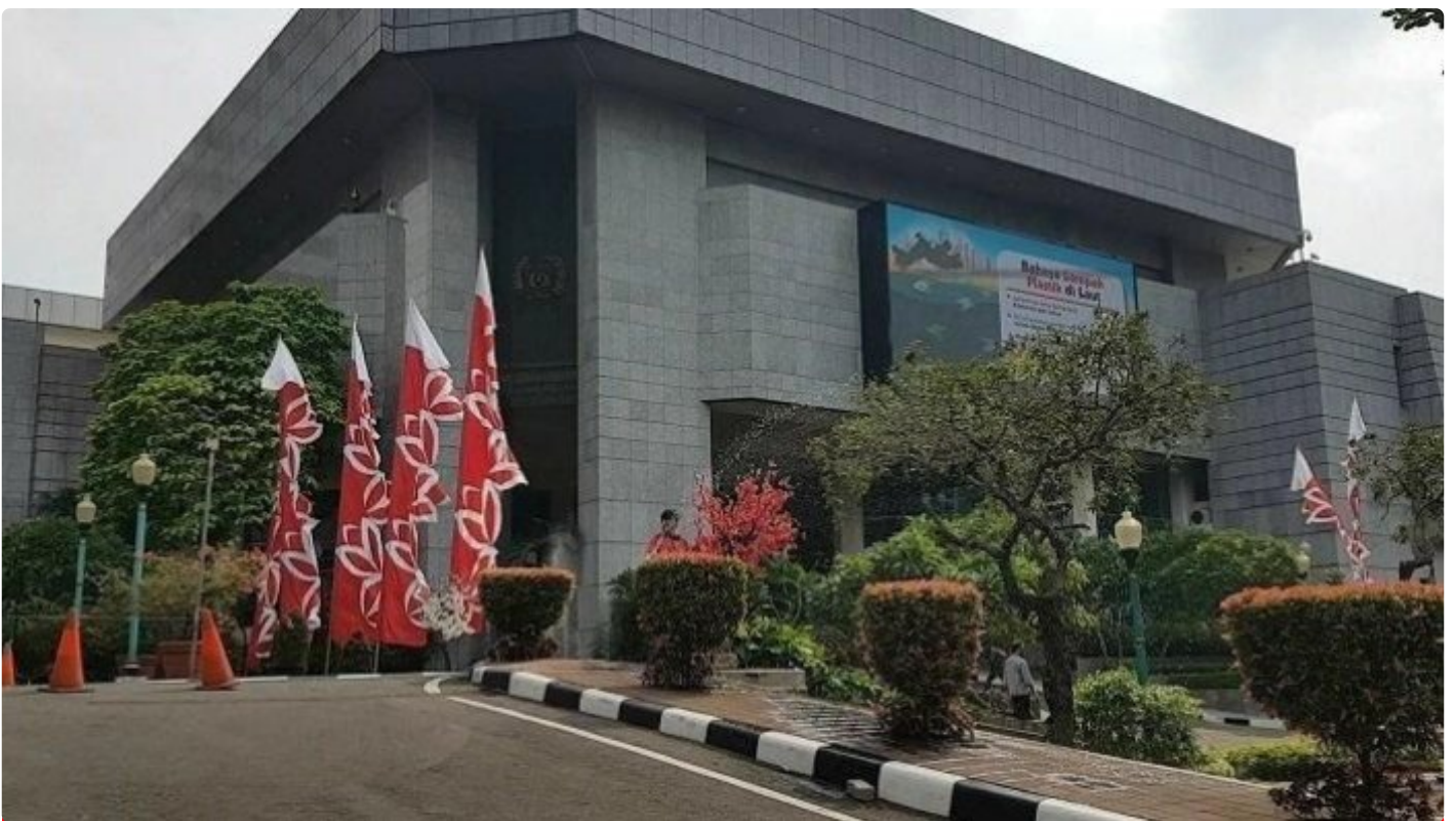
Gedung DPRD DKI Jakarta Jl.Kebon Sirih, Jakarta Pusat
